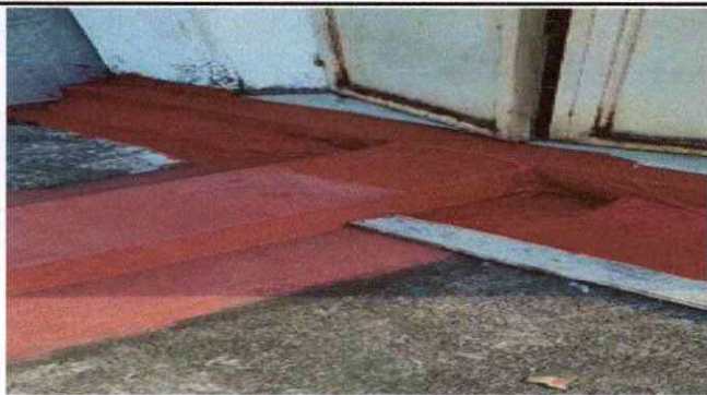
Foto 5: REPARACION DE JUNTA SISMICA, EN MODULO DE SALONES DE DOS EDIFICIOS COMPARTIDO CON JORNADA MATUTINA
