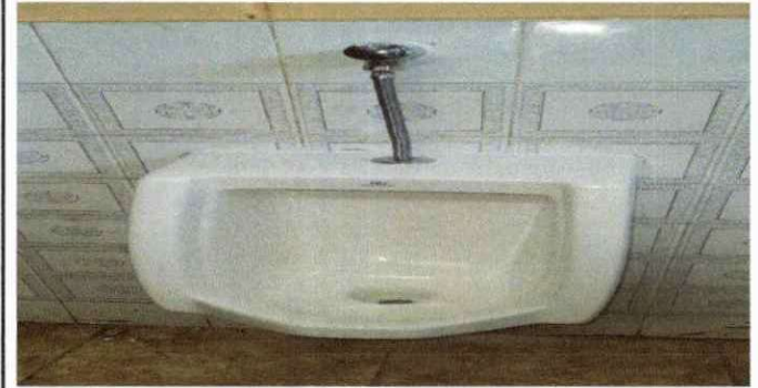
Foto 8: SUSTITUCIÓN DE MINGITORIOS EXISTENTES EN MAL ESTADO POR NUEVOS
