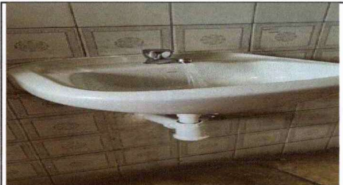
Foto 10: SUSTITUCIÓN DE 10 LAVAMANOS, 10 SIFONES VÁLVULA DE LAVAMANOS, CONTRA LLAVES DE MEDIA A LA PARED, CAMBIO DE LLAVE DE LAVA MANOS, EXISTENTES.
