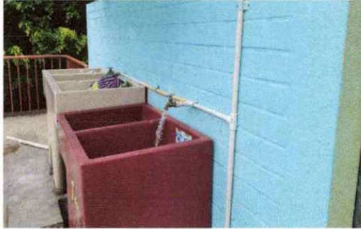
Foto 7: SUSTITUCIÓN DE PILETA DE PISO UBICADA FRENTE A LOS TALLERES DE COCINA POR UNA PILA PLÁSTICA DE UN LAVADERO TALISHE.
