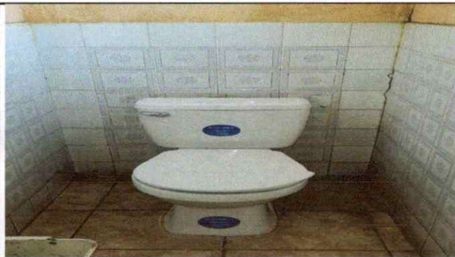
Foto 9: SUSTITUCIÓN DE 8 INODOROS EN MAL ESTADO POR INODOROS NUEVOS
