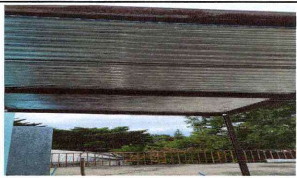
Foto 6: DESMONTAJE DE 3 LAMINAS EN MAL ESTADO Y CAMBIARLAS POR 4 NUEVAS DE 12 PIES
