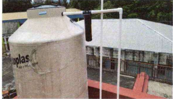
Foto 2: INSTALACIÓN DE 1 DEPÓSITO DE AGUA DE 1100 LITROS MARCA ROTOPLAS.
