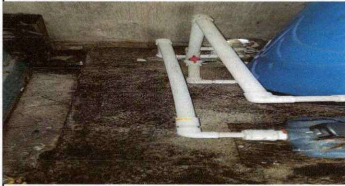
Foto1: SUSTITUCIÓN DE TUBERÍA DE BOMBA. INCLUYE, CONEXIÓN HIDRÁULICA, ELÉCTRICA MATERIALES Y ACCESORIOS NECESARIOS, ACCESORIOS DE PVC Y TUBERÍA
